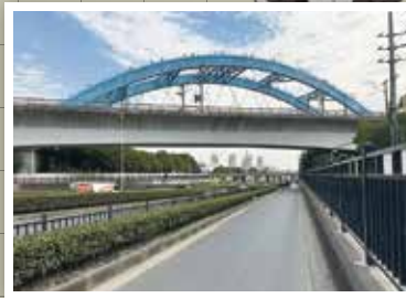
高速鉄道の高架には3路線が通る
